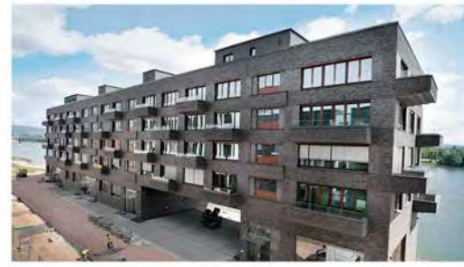
Fertiggestellt: Rheinkai 500 KAIRO 7.000 qm Geschossfläche Eigentumswohnungen, Büro
