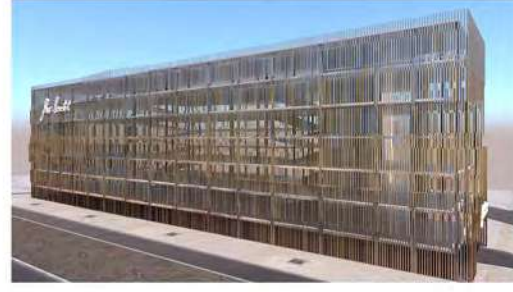
In Betrieb: Quartiersgarage CA Immo Deutschland GmbH 9.200 qm Geschossfläche Garage
