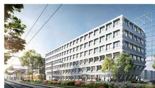
In Bau: ZigZag CA Immo Deutschland GmbH 12.000 qm Geschossfläche Büro
